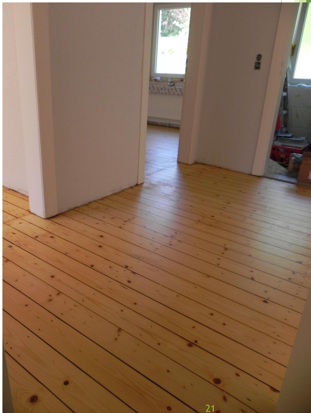
Aufbereitung des Holzbodens
